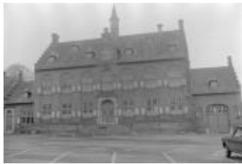
Gemeentehuis Westrozebeke, december 1972 (PV2015_032-05)
