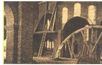
Interieur van kerk in opbouw, Slypskapelle (NR_20121019_256)
