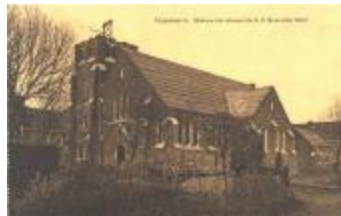
Opbouw nieuwe kerk, Slypskapelle, 11 november 1930 (NR_20121019_255)
