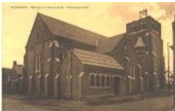
Opbouw nieuwe kerk, Slypskapelle, 11 november 1930 (NR_20121019_254)
