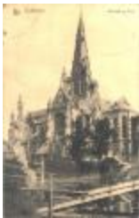
Beschadigde kerk en brug in kasteelpark, Dadizele (NR_20121019_063)
