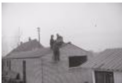
Chirojeugd Staden bouwt, Staden februari 1973 (PV2015_027-06-08)
