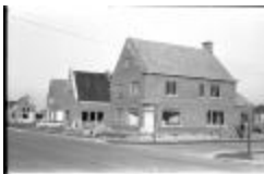
Huizen in opbouw: Berkenweg Hoek, Izegem 1958 (MT1958_2493-2494)
