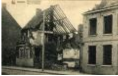
Puin woning Rumbeeksesteenweg na bombardement, WO I (SARAVMF020177)
