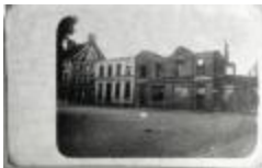
Huizen op Kerkplein Rumbeke in puin, 1918 (SARAVMF017620)
