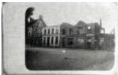
Huizen op Kerkplein Rumbeke in puin, 1918 (SARAVMF017620)
