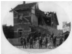
Foto gebombardeerde rechterhelft woning (HKkvdp2008_003)
