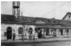
Stationsgebouw Lichtervelde (HKkvd2008_002)
