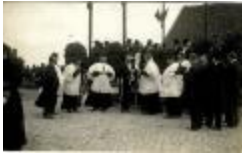
Installatie Van Ryckeghem, Krottegem, 1911 (SARAVMF000191)
