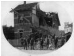
Foto gebombardeerde rechterhelft woning (HKkvdp2008_003)
