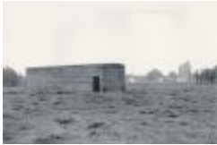
Bunker, Eerste Wereldoorlog, Lichtervelde (KIBGLIC_20121007_010)
