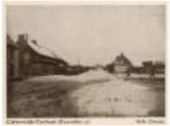
Straat Lichtervelde-Torhout, december 1917 (KIBGLIC_20121007_005)
