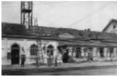
Stationsgebouw Lichtervelde (HKkvd2008_002)
