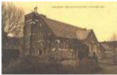
Opbouw nieuwe kerk, Slypskapelle, 11 november 1930 (NR_20121019_255)
