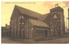
Opbouw nieuwe kerk, Slypskapelle, 11 november 1930 (NR_20121019_254)
