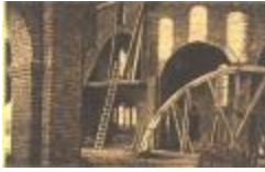
Interieur van kerk in opbouw, Slypskapelle (NR_20121019_256)
